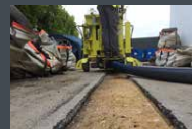
Rabotage d'enrobés avec aspiration à la source
