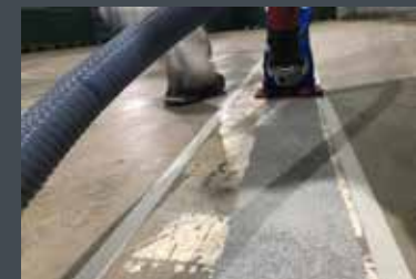
Décapage de surface avec aspiration à la source
